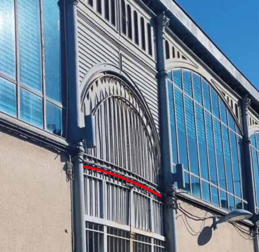
▲ Déformation importante de l'arcature de la porte latérale.
