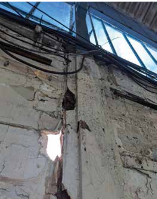
▼ Poteau perforé avec absence de matière et corrosion par feuilletage très avancée, ailettes d'ancrage disloquées et fissurées.
