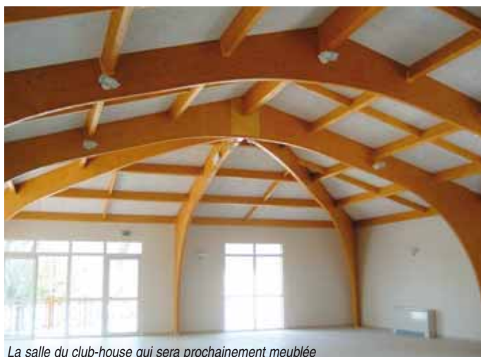
La salle du club-house qui sera prochainement meublée
